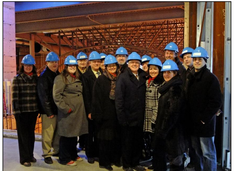
Le Conseil des gouverneurs et des membres de la direction du CCNB visitent le chantier de construction du nouvel établissement du CCNB à Edmundston.
